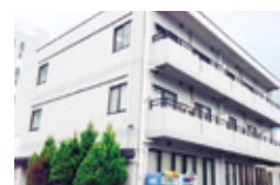
店舗の主要な外観
