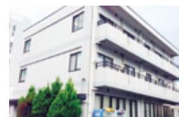
店舗の主要な外観
